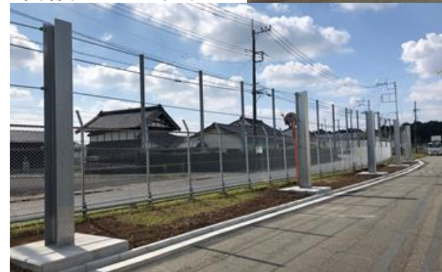
防護フェンス設置
