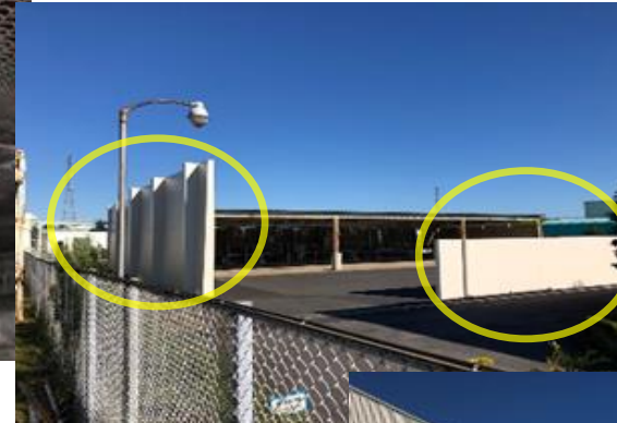
高圧ガス貯蔵所障壁設置
