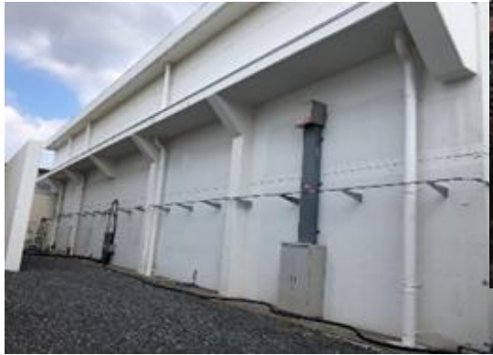
外壁補強(スラブ設置)
