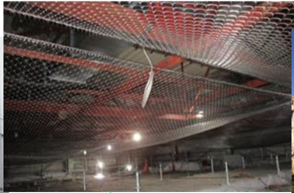
天井裏防護ネット設置
