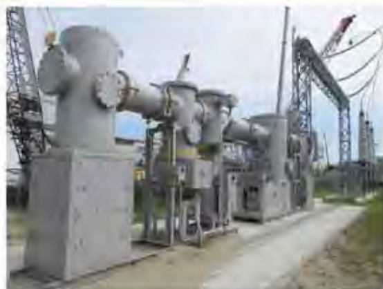
ガス絶縁開閉装置への設備変更
