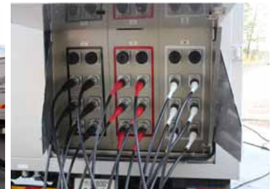
ケーブル接続箇所(低圧電源車側)
