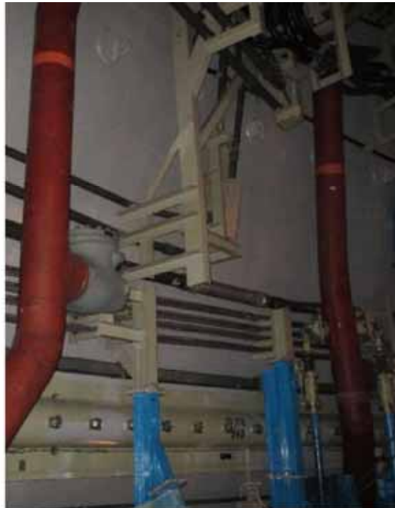
仮設足場組立前
