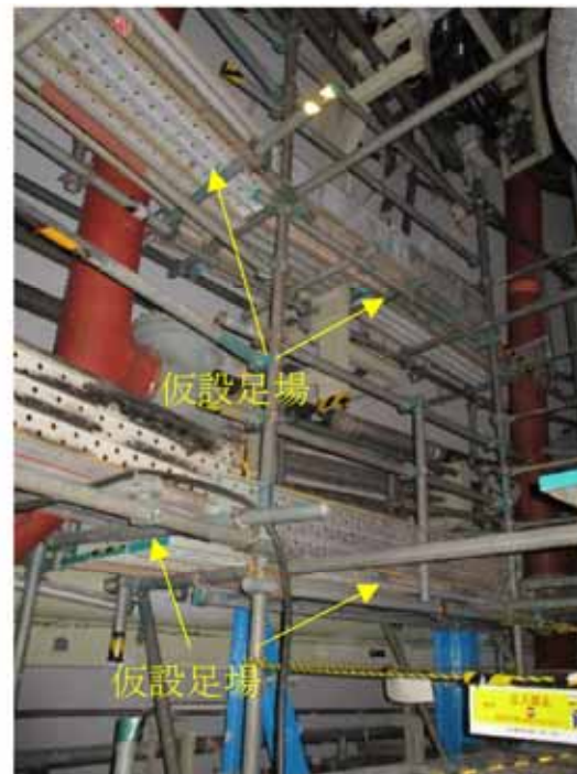
仮設足場組立後
