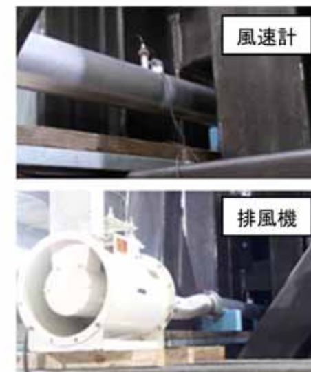
排風機及び風速計設置状況
