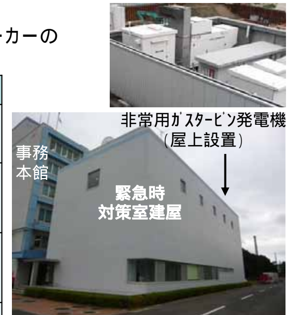
緊急時対策室建屋 (当時施工中)*
