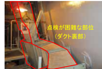
例 ダクト裏部
