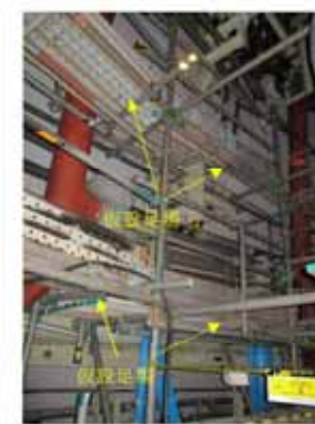
仮設足場組立後
