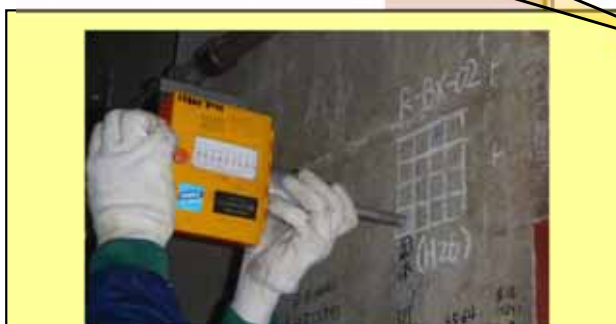
非破壊試験結果による点検箇所を選定 (リバウンドハンマー試験による表面状態の確認)
