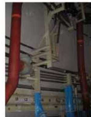
仮設足場組立前
