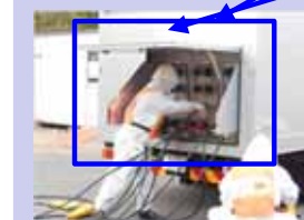
可搬型代替低圧電源車のケーブル接続作業
