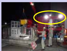
暗所環境下での可搬型代替注水ポンプ車の設置・運用
