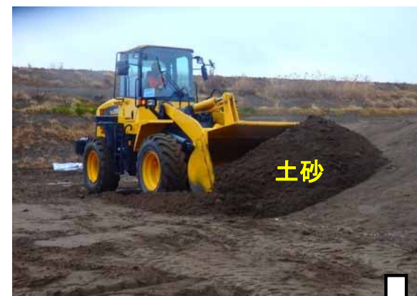
重機により土砂を撤去
