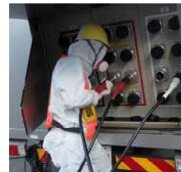
( 実機による訓練 )可搬型代替低圧電源車の設置・運用
