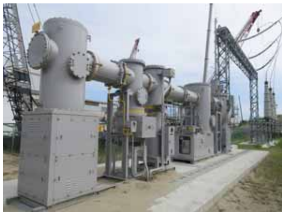
ガス絶縁開閉装置への設備変更
