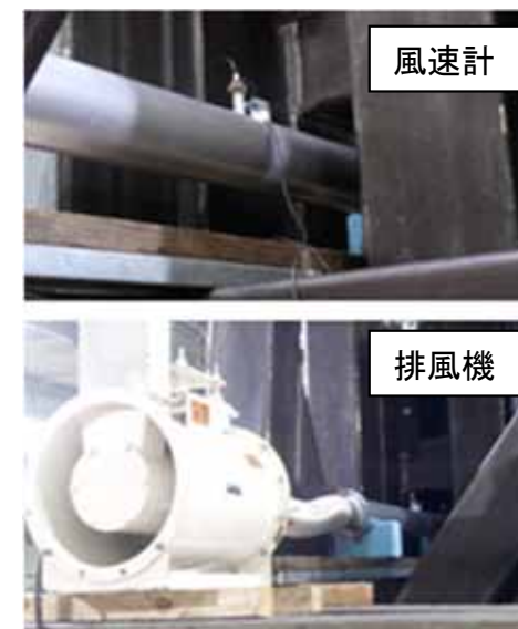
排風機及び風速計設置状況
