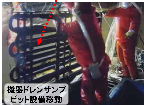
図1 ペDESTAL内既存設備の移動・除染作業 論点No.200, 206-4
