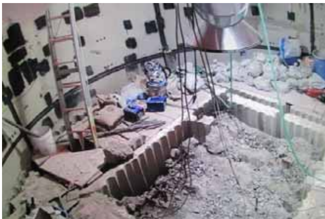
図2 既存床コンクリートはつり作業
