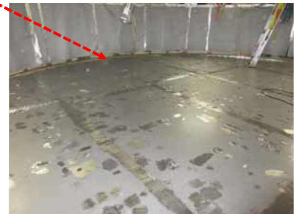
図4 床コンクリート埋め戻し及びライナ設置状況
