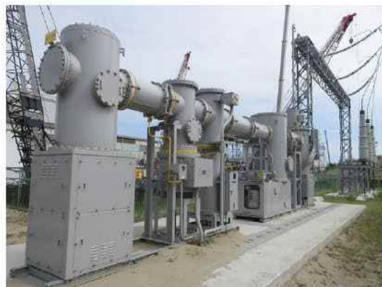
ガス絶縁開閉装置への設備変更
