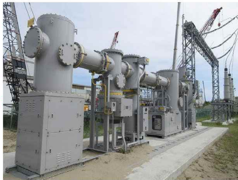
[対策例] 154kV開閉所 ガス絶縁開閉装置(取替後)
