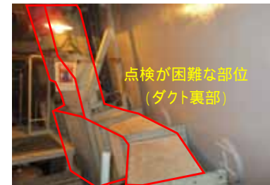
例 ダクト裏部
