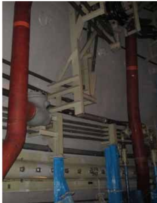
仮設足場組立前
