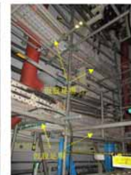
仮設足場組立後
