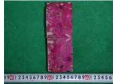
中性化深さの点検状況 (フェノールフタレイン溶液による確認)
