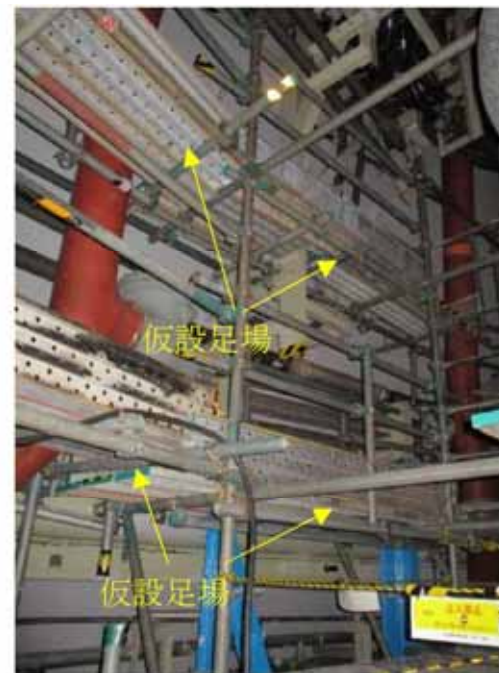
仮設足場組立後
