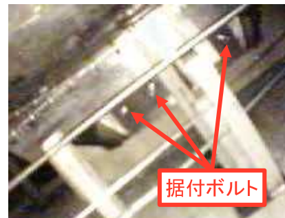
③据付ボルトの観察 (予備貯槽)
