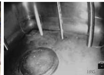
④ドリフトレイ集液部の観察 (予備貯槽)
