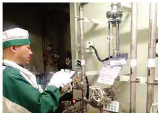
② 日常点検(エア流量の確認)
