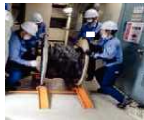
可搬型蒸気供給設備 (本設備が使用できない場合の漏えい液移送用蒸気設備)
