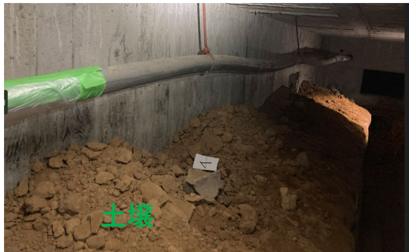
第一実験棟床下
