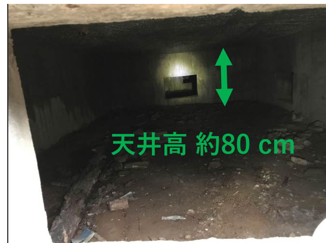
第一実験棟床下
