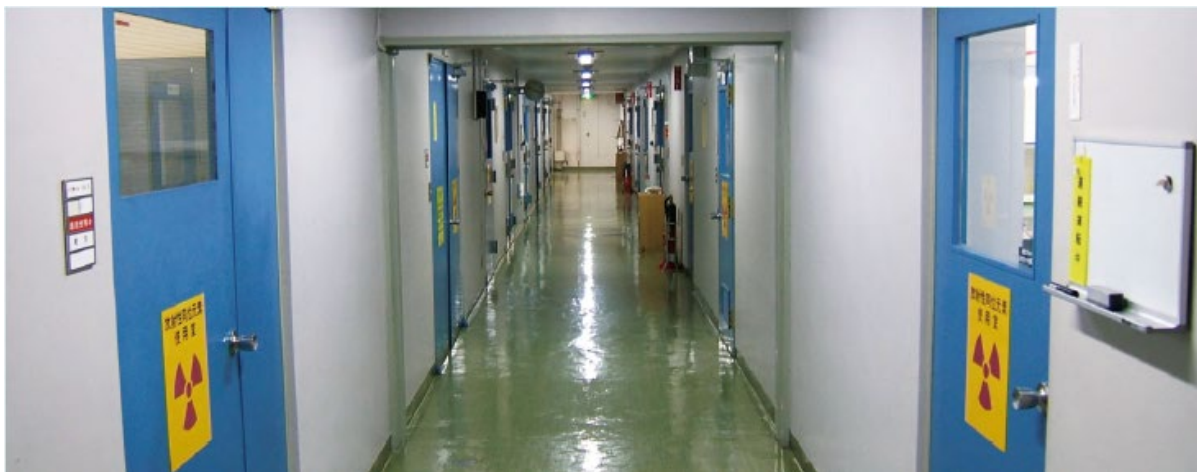
図2-2 第一実験棟屋内
