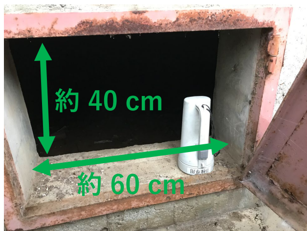
第一実験棟床下入口
