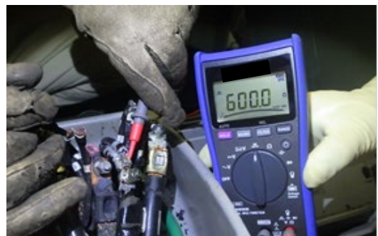
断線ケーブルの導通測定： 6 0 0. 0 \Omega
