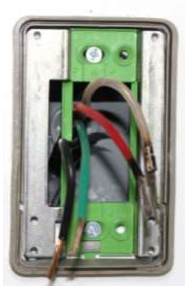
図 2 - 1 1 当該コンセントの内部配線状況
