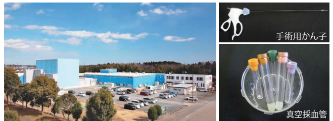
日本照射サービス(株)東海センターの外観
