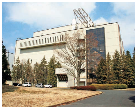
JT-60実験棟の外観 ©QST
