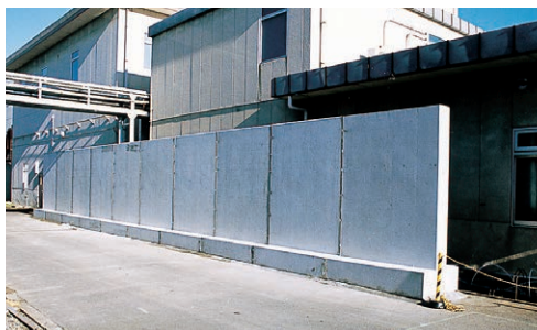
事故施設周辺のコンクリート遮へい壁
