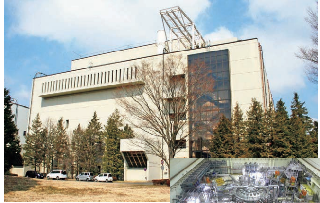
JT-60実験棟の外観 ©QST
