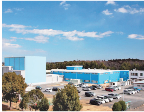
日本照射サービス(株)東海センターの外観
