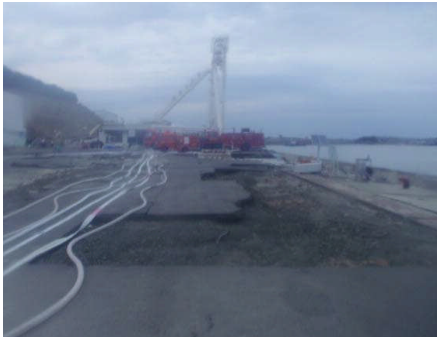
3号機への消防車による注水作業
