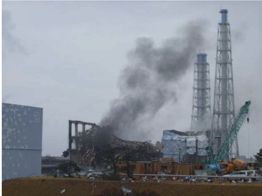
爆発後の3号機の外観（3月21日）
