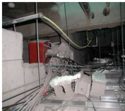
原子力専攻 研究棟2F (ケーブルダクトピット壁内崩落)
