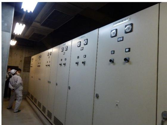
写真2-1 地下にある受変電設備
