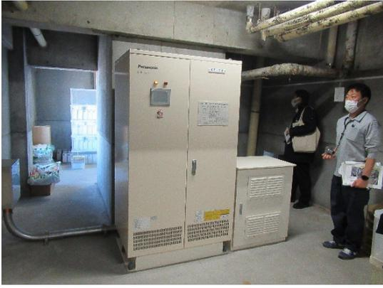
写真3-1 塔屋の太陽光発電用の蓄電池
