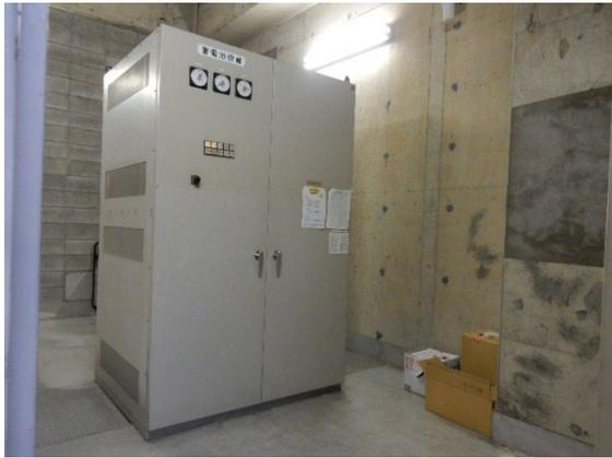
写真2-3 非常用発電を稼動するための鉛蓄電池
