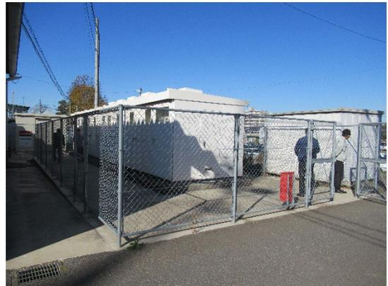
写真3-6 庁舎北側に設置されている受変電設備
