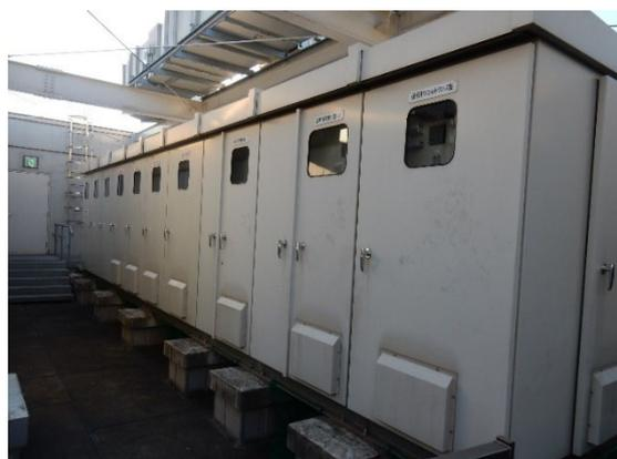
写真5-2 施設中央に設置されている受変電設備
