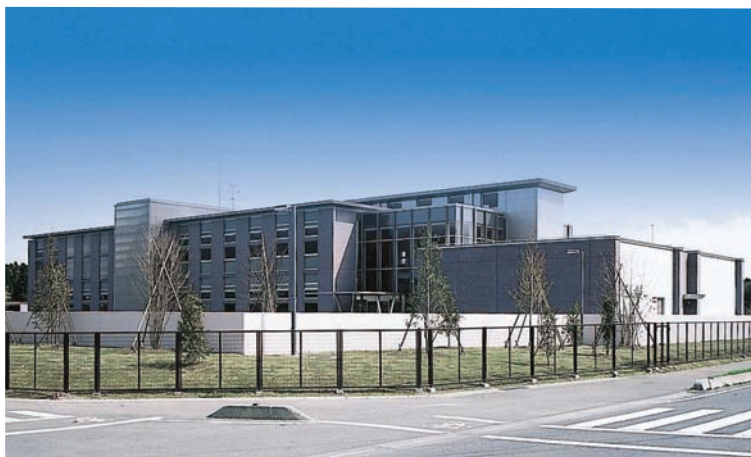
環境放射線監視センター
