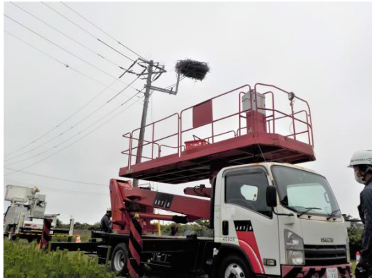
巣からヒナを捕獲するための作業車 (いずれも神栖市、令和5年6月15日)
