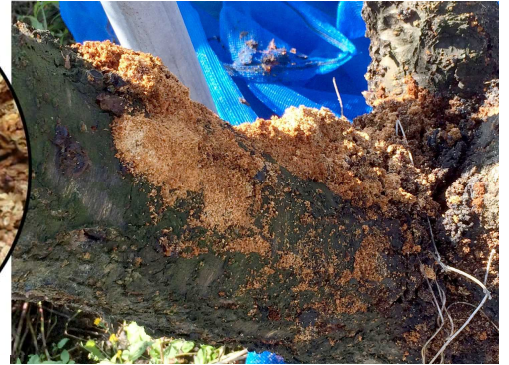
堆積したフラス 被害を受けた木の根元や幹の股などには、排出口から落ちたフラスが大量に堆積します。樹液が混ざるとペースト状になります。
