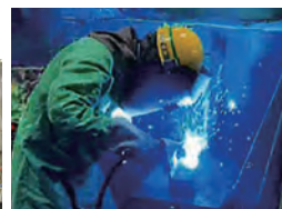
半自動溶接 (日立建機(株))
