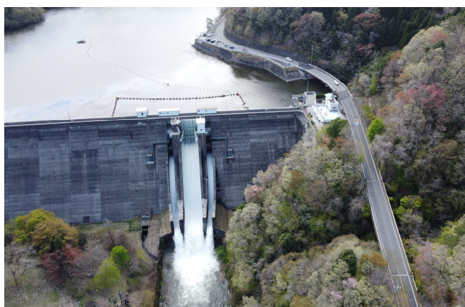
【前回実施状況（全放流口からの放流状況）】
