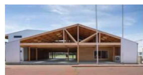
【空間・建築部門】 茗溪学園トレーニング・部室棟
