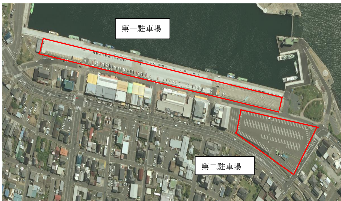
図 那珂湊漁港駐車場全景
