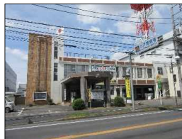
古河警察署現況 (S41年3月築)
