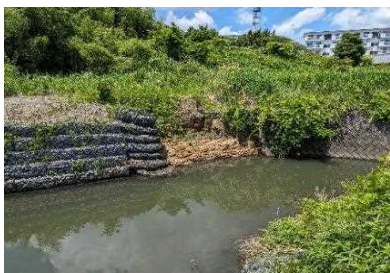
護岸改修 沢渡川(水戸市)
