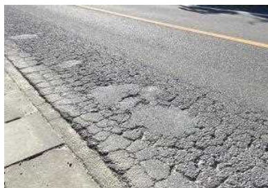
舗装修繕 取手つくば線(つくばみらい市)
