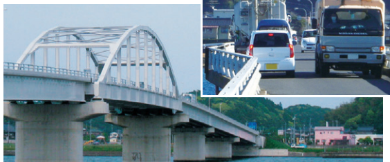
老朽橋の架替を含むバイパス整備 国道354号北浦バイパス（銚田市、行方市）
