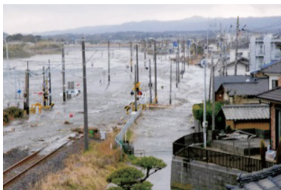
東日本大震災では津波襲来により 国道6号が浸水（北茨城市）
