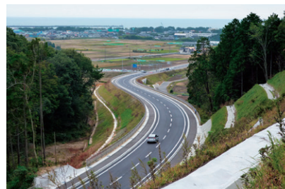
国道6号の代替ルート整備 里根神岡上線バイパス（北茨城市）
