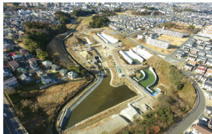
中丸川(調節池整備)
