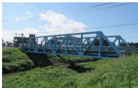
図 3.2 下路橋(トラス)／長岡橋
