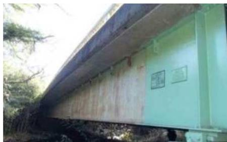
図 3.4 部分塗装の施工例
