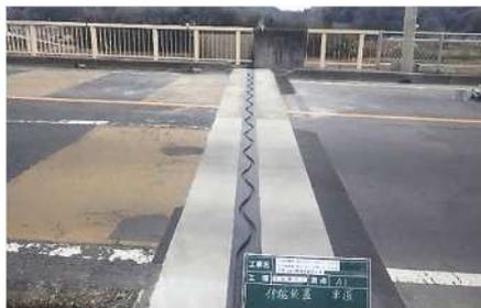
図 3.3 非排水性の伸縮装置の設置
