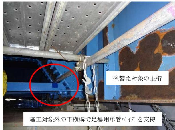
図解-1.2.2 施工対象範囲外の下横構を利用して足場を支持している施工例
