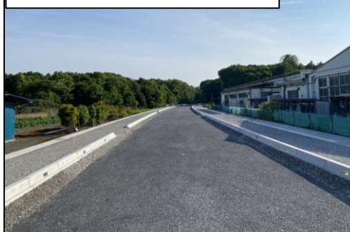
②工事状況（小岩戸地内）
