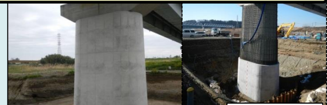
施工中の様子
