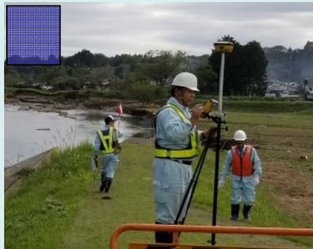
被災状況調査 【(公社)茨城県測量・建設コンサルタント協会】
