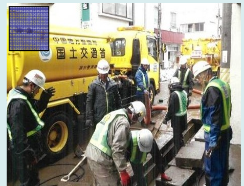
浸水による泥の清掃作業 【国土交通省・(一社)茨城県建設業協会】
