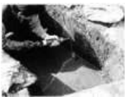
水路のひび割れ補修
