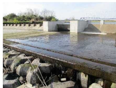
ため池等整備事業（河川応急） 村田堰地区
