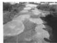
農道の窪みの補修
