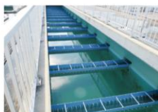
やくひんちんでんち 薬品沈殿池
