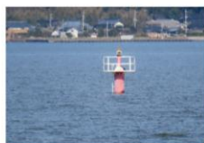
しゅすいとう 取水塔
